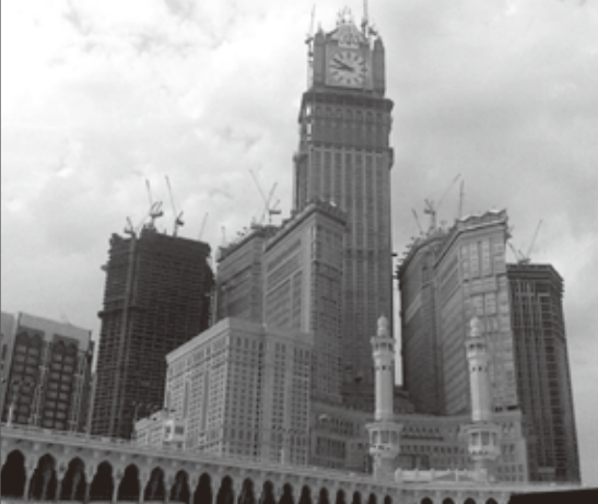
2010年在麦加建造中的阿巴特大楼群 (The Abraj Al Bait Towers)。将于2011年竣工。
